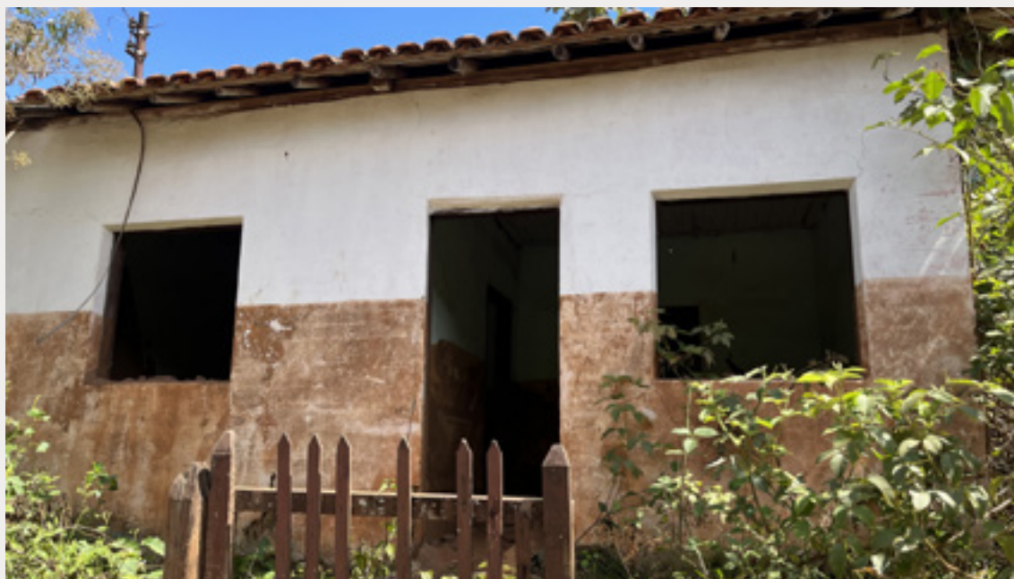
Linha deixada pela lama em uma casa atingida pelo rompimento da barragem de rejeitos em Mariana, foto registrada em 27 de Agosto de 2022
