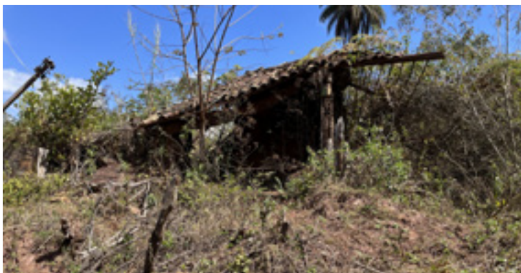
Uma casa destruída pela lama em Mariana. À medida que descíamos o morro, as marcas ficavam cada vez mais altas nas laterais dos prédios, até que ficou claro que os prédios haviam sido cobertos pela lama, foto registrada em 27 de Agosto de 2022
