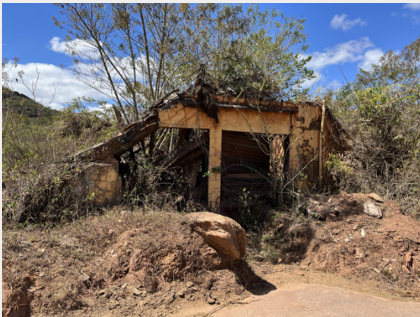
Estrutura destruída pelo rompimento da barragem de rejeitos de Mariana, foto registrada em 27 de Agosto de 2022
