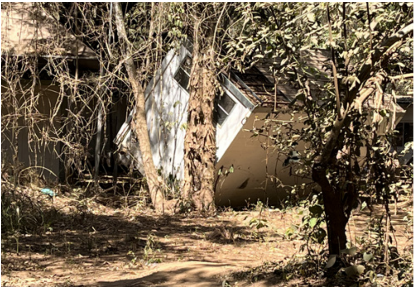
Prédio derrubado pela lama do rompimento da barragem de rejeitos em Brumadinho, foto registrada em 18 de Agosto de 2022
